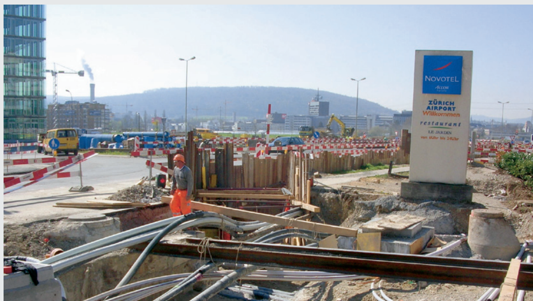
Abbildung 4: Werkleitungsumlegungen am Lindbergh-Platz in Opfikon
