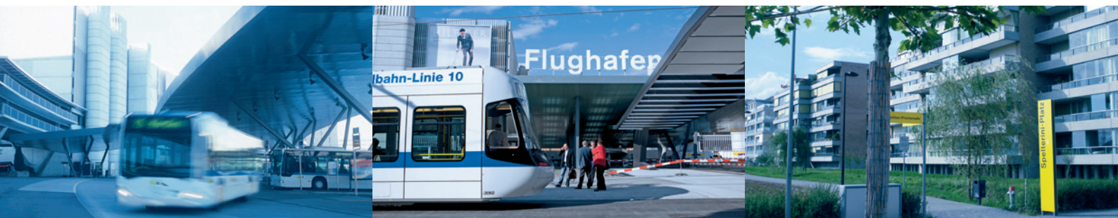
Abbildung 3: Der Bushof und die neue Glattalbahn am Flughafen Zürich; der neu gebaute Stadtteil Glattpark in Opfikon
