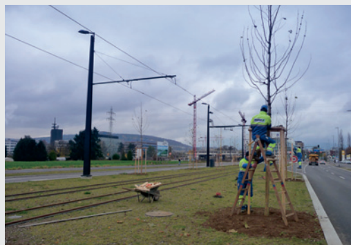
Abbildung 5: Bewilligte Fertigstellungsarbeiten entlang des Trassees bei Streckensperrung
