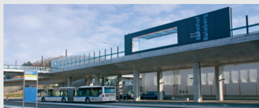
Abbildung 8: Bau der ÖV-Drehscheibe Bahnhof Balsberg
