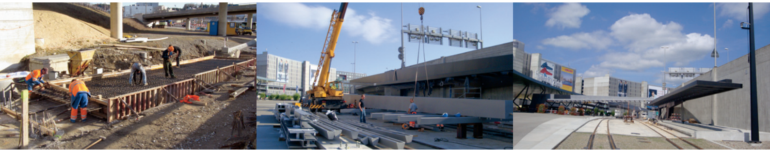
Abbildung 7: Entstehung der Glattalbahn-Haltestelle Zürich Flughafen
