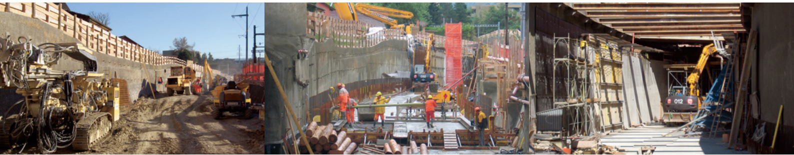
Abbildung 4: Bau des Margarethentunnels
