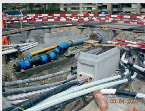
Abbildung 1: Werkleitungsarbeiten in der Thurgauerstrasse
