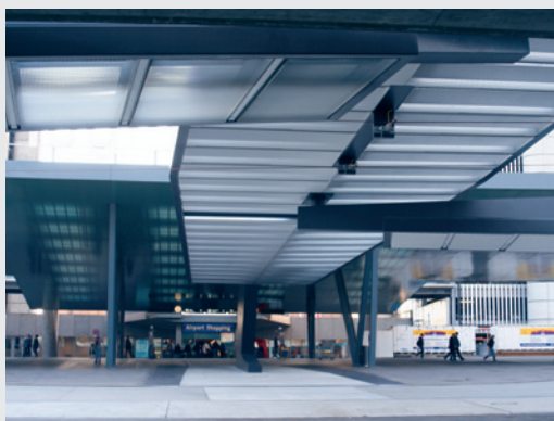
Abbildung 8: Eine ausbalancierte Konstruktion und Statik lässt das weit ausragende Mitteldach auf den beiden Perrondächern liegen.
