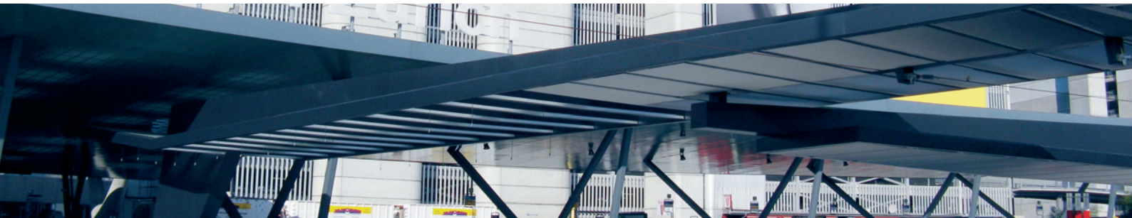
Abbildung 7: Das neue Verbindungsdach zwischen dem Bushof und der Glattalbahn-Haltestelle Zürich Flughafen
