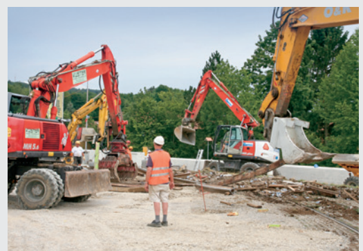
Abbildung 2: Bahnhof Stettbach – Rückbau bestehende Gleisanlage
