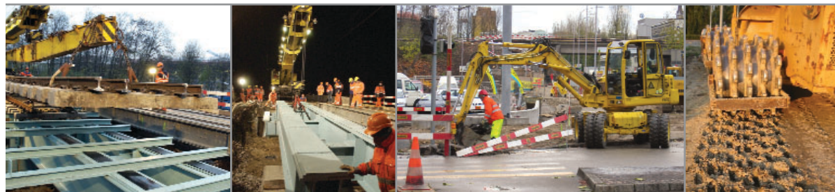
Impressionen der ersten Bauarbeiten der Glattalbahn
