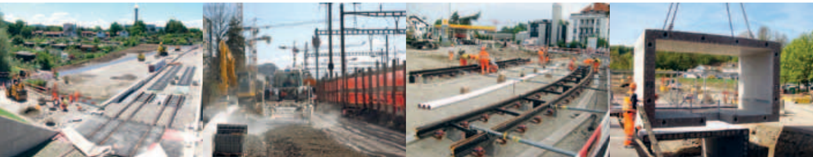
Construction des voies dans le secteur des jardins familiaux
