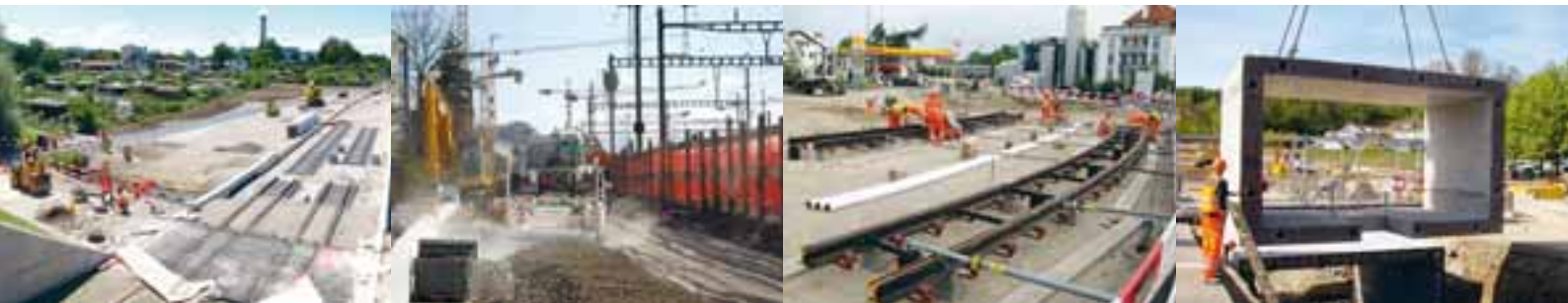
Gleisbauarbeiten im Areal der Familiengärten
