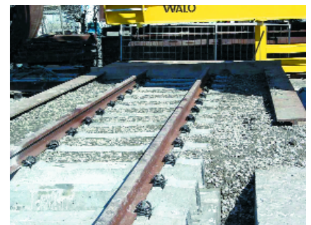
Gleis vor Einbau des Schotterrasens.
