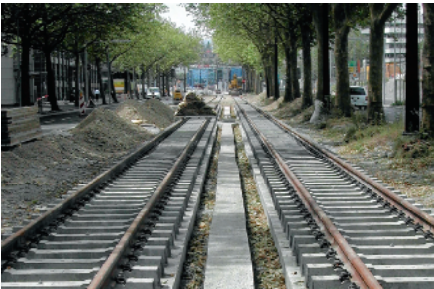
Bild 3a: Fahrbahn Typ B im Einbau: Phase 1.
