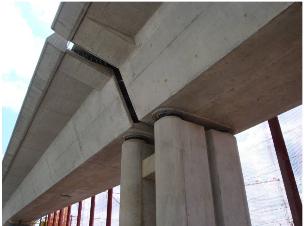
Abbildung 11: Verbindung der benachbarten Randstützen
